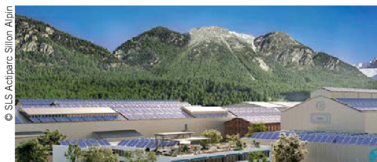
Le site du Cheylas est à énergie positive depuis 2023.
