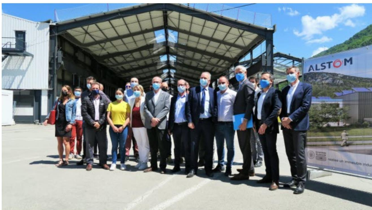
Pierre Michard, vice-président Services d'Alstom France, et Laurent Wauquiez, président la région Aura, ont rencontré ce vendredi les équipes travaillant sur le chantier du Cheylas et les entreprises déjà installées sur l'ancienne friche Ascométal. Photo Le DL /Matthieu ESTRANGIN
